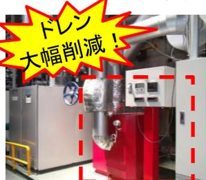
従来の貫流式ボイラーは、乾き度が低い湿り蒸気を生成させ、配管中に多くのドレンを生じさせている。このドレンは多くの場合捨てており、過剰なエネルギー消費につながってしまっている。そこでサイクロン式蒸気改質装置を活用！
