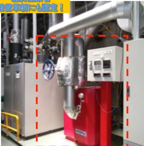
ほとんどの貫流式ボイラーは乾き度が低く水分の多い蒸気(湿り蒸気)を発生させ、配管中に多くのドレンが生じています。通常、そのドレンは回収・熱交換されてボイラー給水に利用されますが、過剰なドレン排出を招いているケースが多く(15～20%)、この過剰なドレン排出は過剰なエネルギー消費を招いています。
