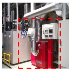
この装置では、水分の多い湿り蒸気を、“**絞り減圧効果**”により乾き度が**アップ**した高温の蒸気に改質します。
